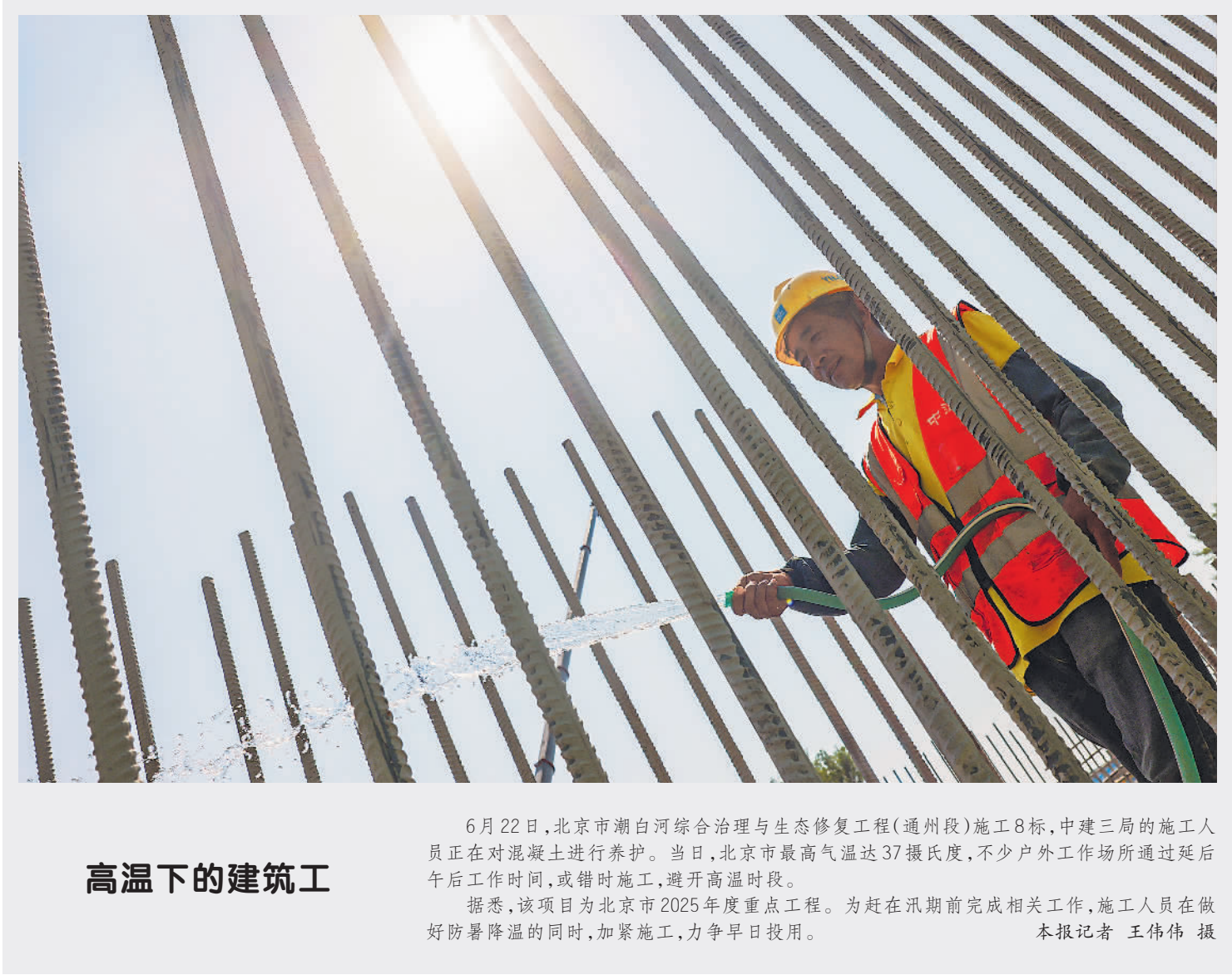
6月22日,北京市潮白河综合治理与生态修复工程(通州段)施工8标,中建三局的施工人员正在对混凝土进行养护。当日,北京市最高气温达37摄氏度,不少户外工作场所通过延后午后工作时间,或错时施工,避开高温时段。 据悉,该项目为北京市2025年度重点工程。为赶在汛期前完成相关工作,施工人员在做好防暑降温的同时,加紧施工,力争早日投用。 本报记者 王伟伟 摄
